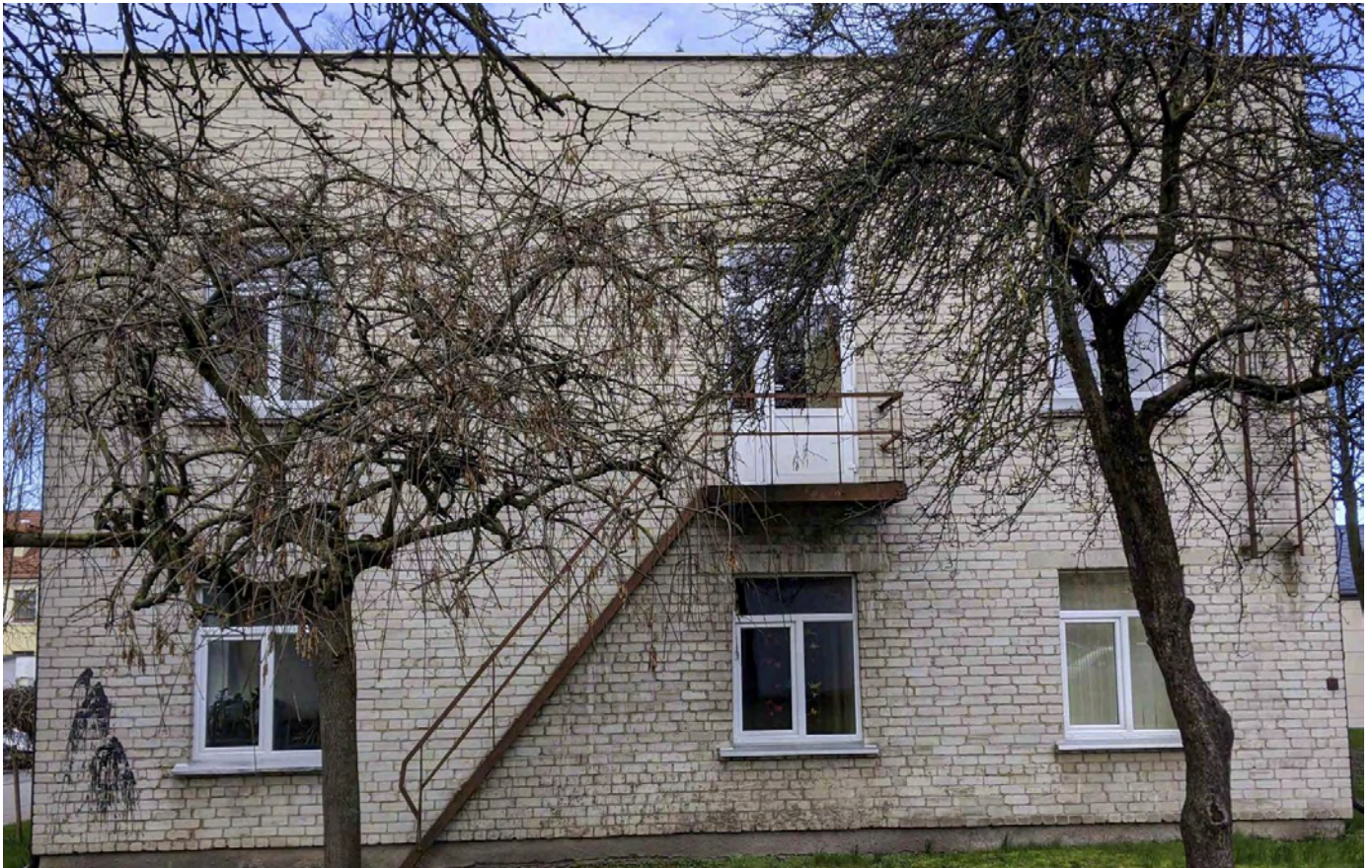
2 pav. Rekonstruojamo pastato vaizdai iš išorės
